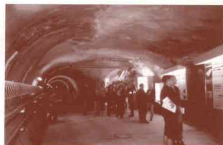
オープンデーでトンネル内は大混雑
